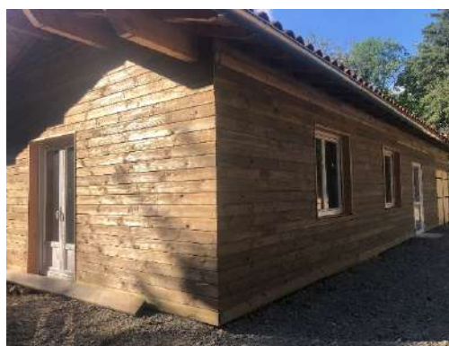
Fin juillet : pose du bardage
