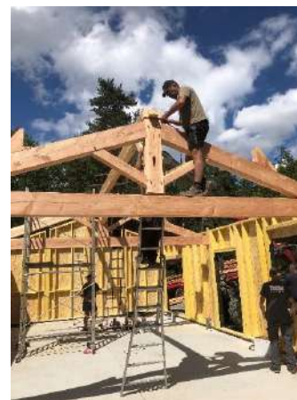
Juin 2020 : fabrication et mise en place des murs et de la charpente
