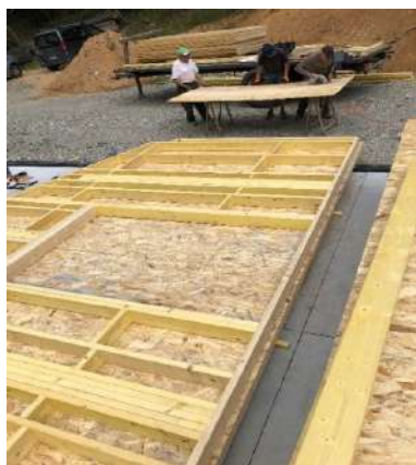
Juin 2020 : fabrication et mise en place des murs et de la charpente
