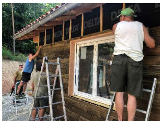
Fin juillet : pose du bardage
